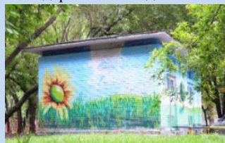
Оформлення фасаду будівлі трансформаторної підстанції
