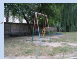
Застаріле обладнання дитячого майданчика
