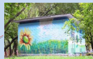
Оновлення фасаду ТП
