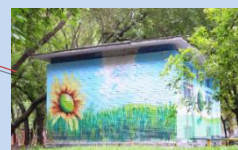
Оформлення фасаду трансформаторної підстанції
