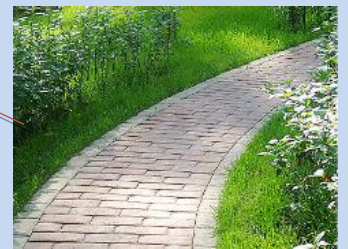
Влаштування мощення доріжок
