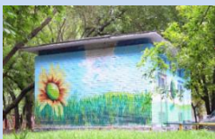
Оновлення фасадів ТП-1986 та ТП-2021
