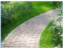
Влаштування мощення доріжок
