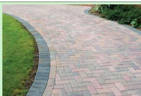
Заміна застарілого асфальтового покриття доріжок (з організацією відведення дощових та талих вод)
