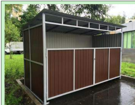
Влаштування закритої (огороженої) споруди навісу зміттєзбірного майданчика
