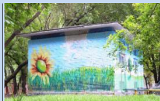
Оформлення фасаду трансформаторної підстанції
